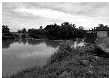
6. ábra • Megújított gát a Rábán
