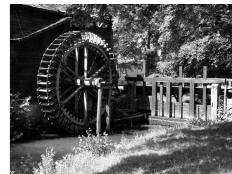
4. ábra • Zsilip alulcsapott járókerékkel
