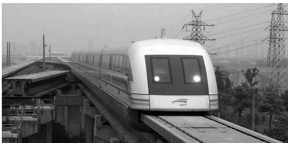
6. ábra • Kettős vágánykapcsolat Sanghajban a Longyang Road állomás előtt
