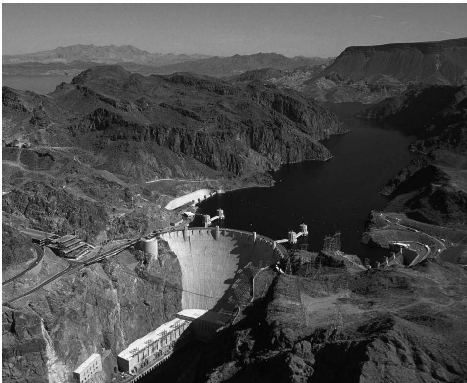
2. ábra • A Hoover-gát vízerőmű, épült: 1931–1935. (forrás: hu.wikipedia.org/wiki/Hoover-gát )
