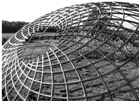
2. ábra • Einar Thorsteinn arany- metszés- pavilonjának szerkezeti váza
